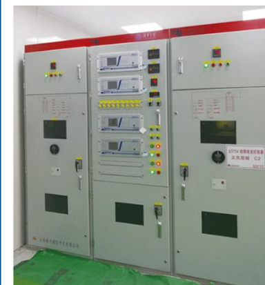
±375V固态式直流断路器
