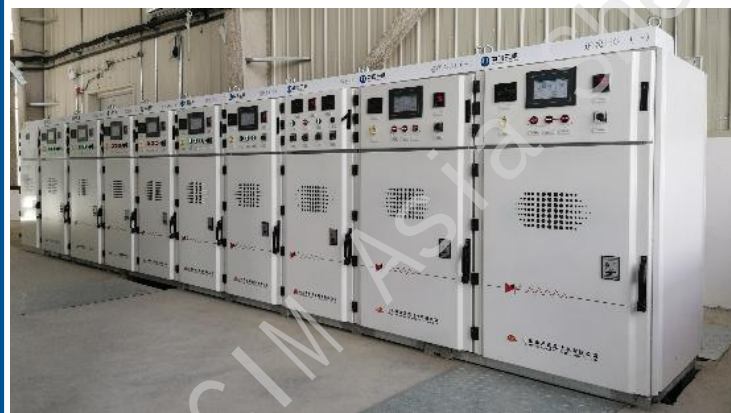
750V固态式直流断路器
