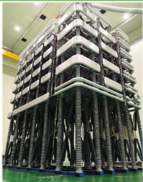
535kV直流断路器
